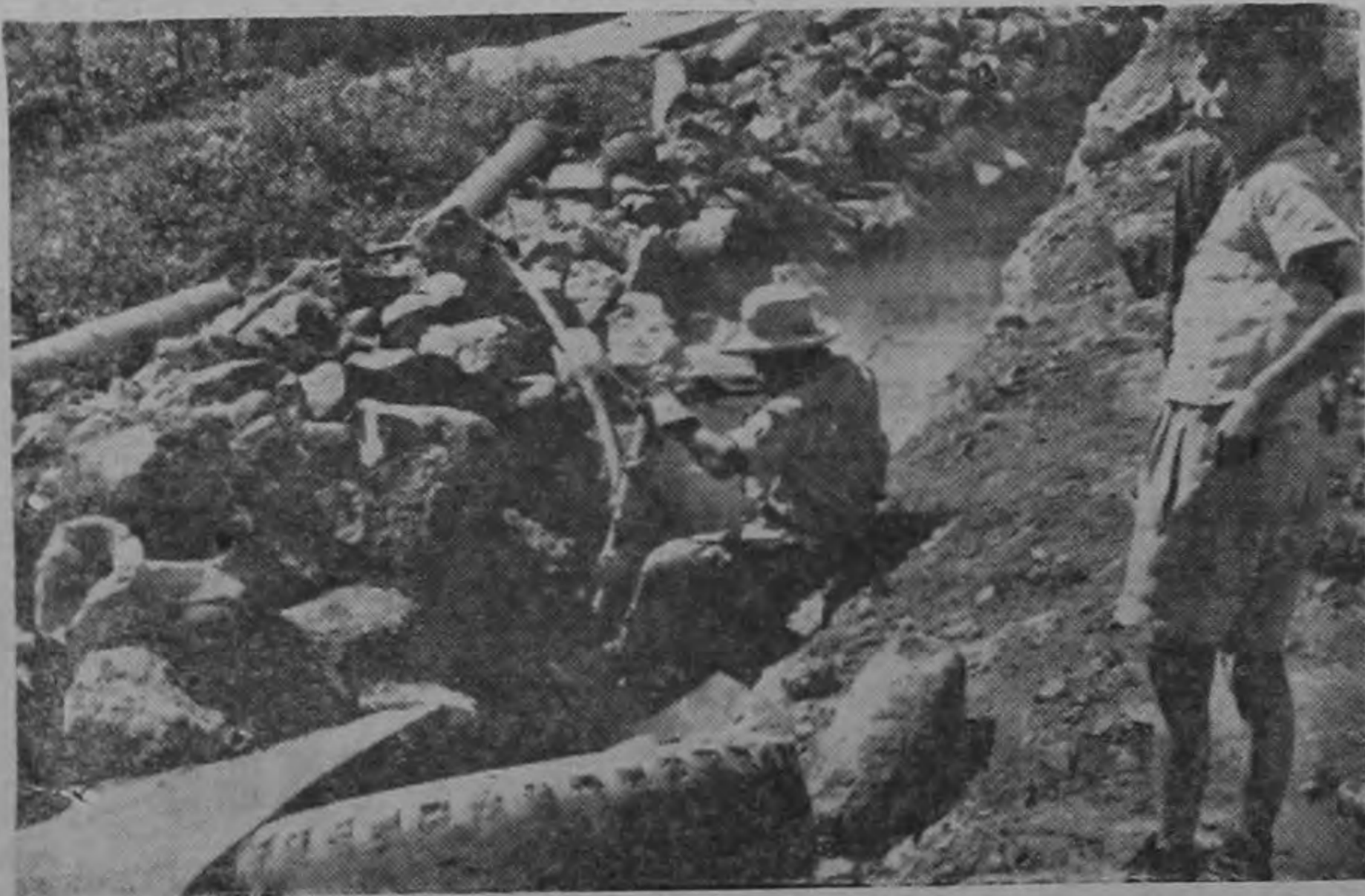
En condiciones adversas, por la naturaleza difícil del terreno, ha tenido que trabajar la Municipalidad de Cartago, para la apertura de la zanja donde ha sido colocada la tubería. Cerca de 8 kilómetros de tendido han dado por terminada esta dura tarea.
